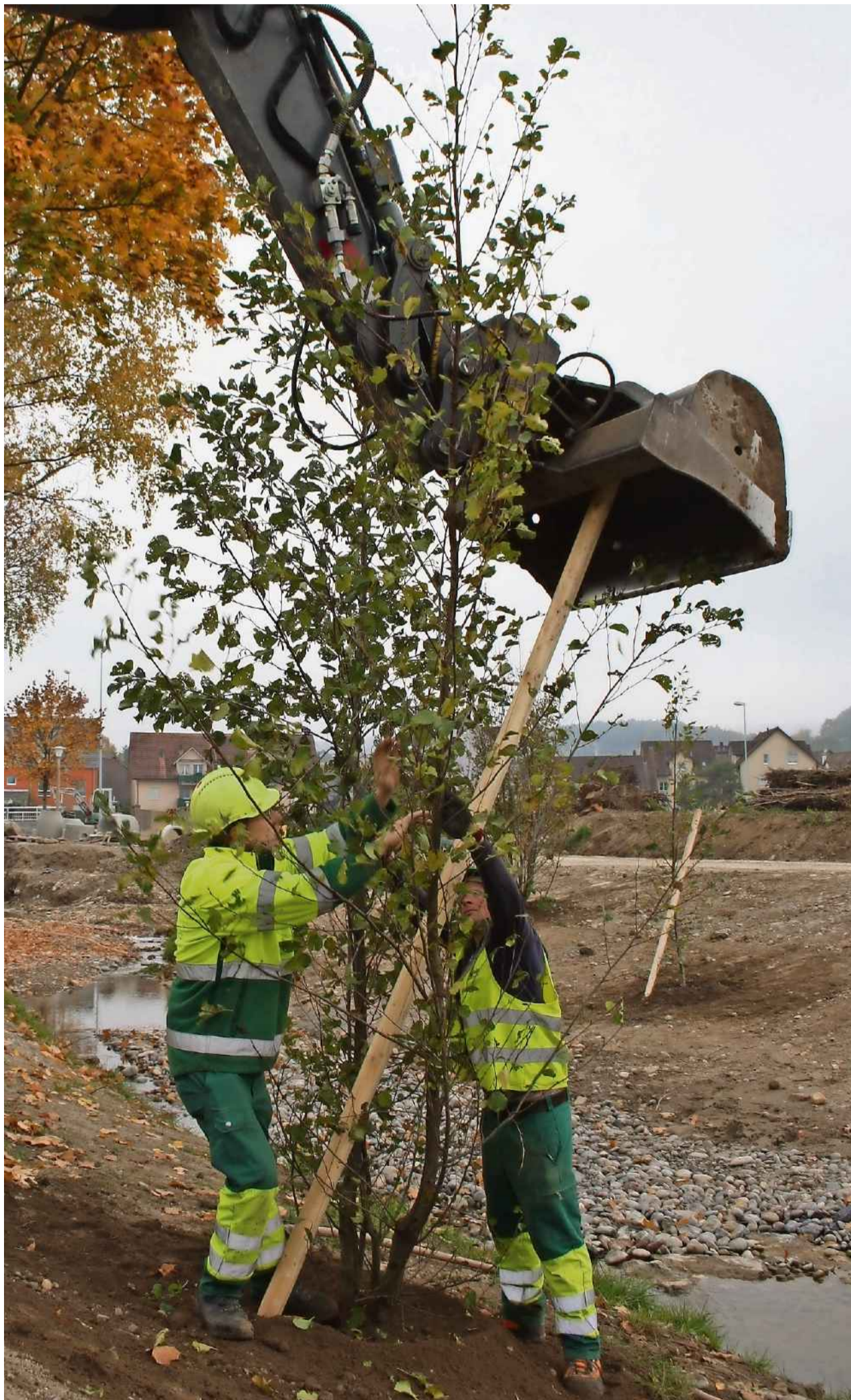
Mit der Baggerschaufel wird der Pfahl in den Boden gedrückt. So soll der Baum stabil bleiben, damit er Wurzeln bilden kann. SIB
